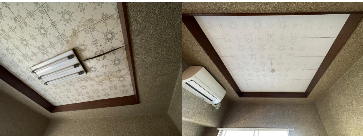
雨漏り補修 左：Before 右：After
