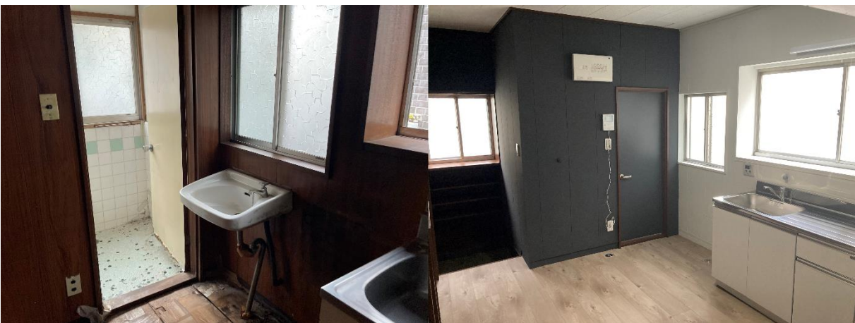
内観② 左：Before 右：After 奥の風呂があった場所は浴槽を撤去し、荷物置き場、バックヤードとして活用。
